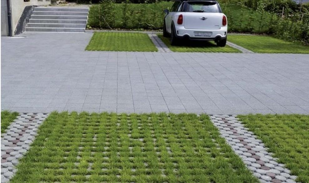
Foto: esempio di pavimentazione drenante in massello<sup>2</sup>
