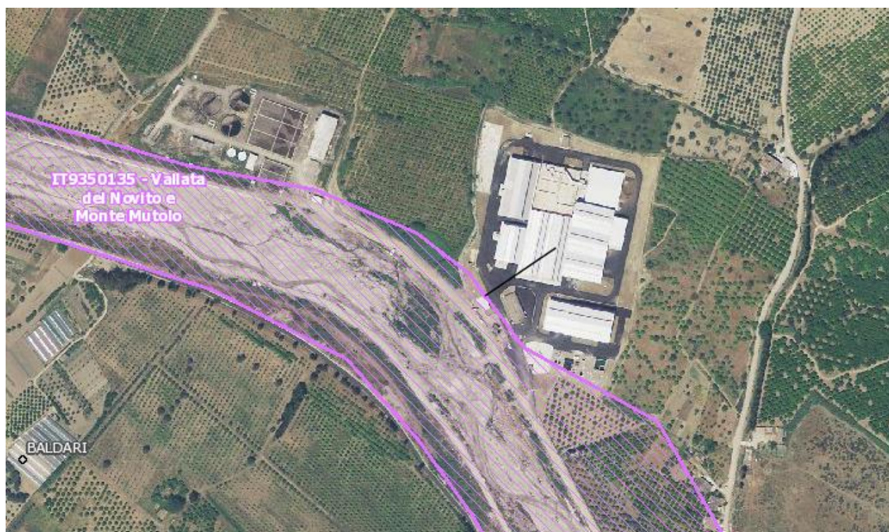
Figura 6.38 Impianto pubblico esistente di Siderno da revampare
