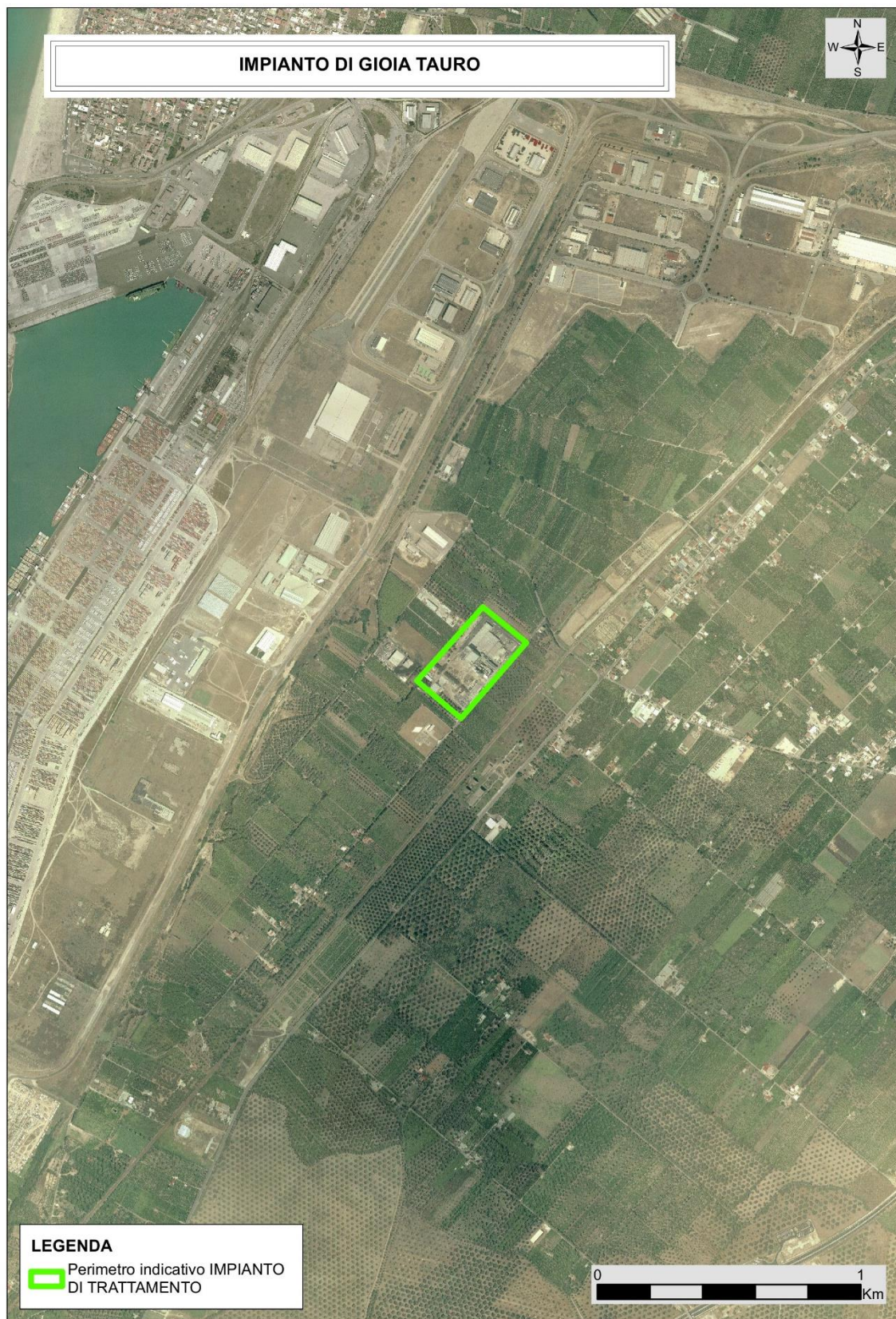
Figura 13 Inquadro delle aree soggette a tutela ambientale – Impianto da revampare di Gioia Tauro
