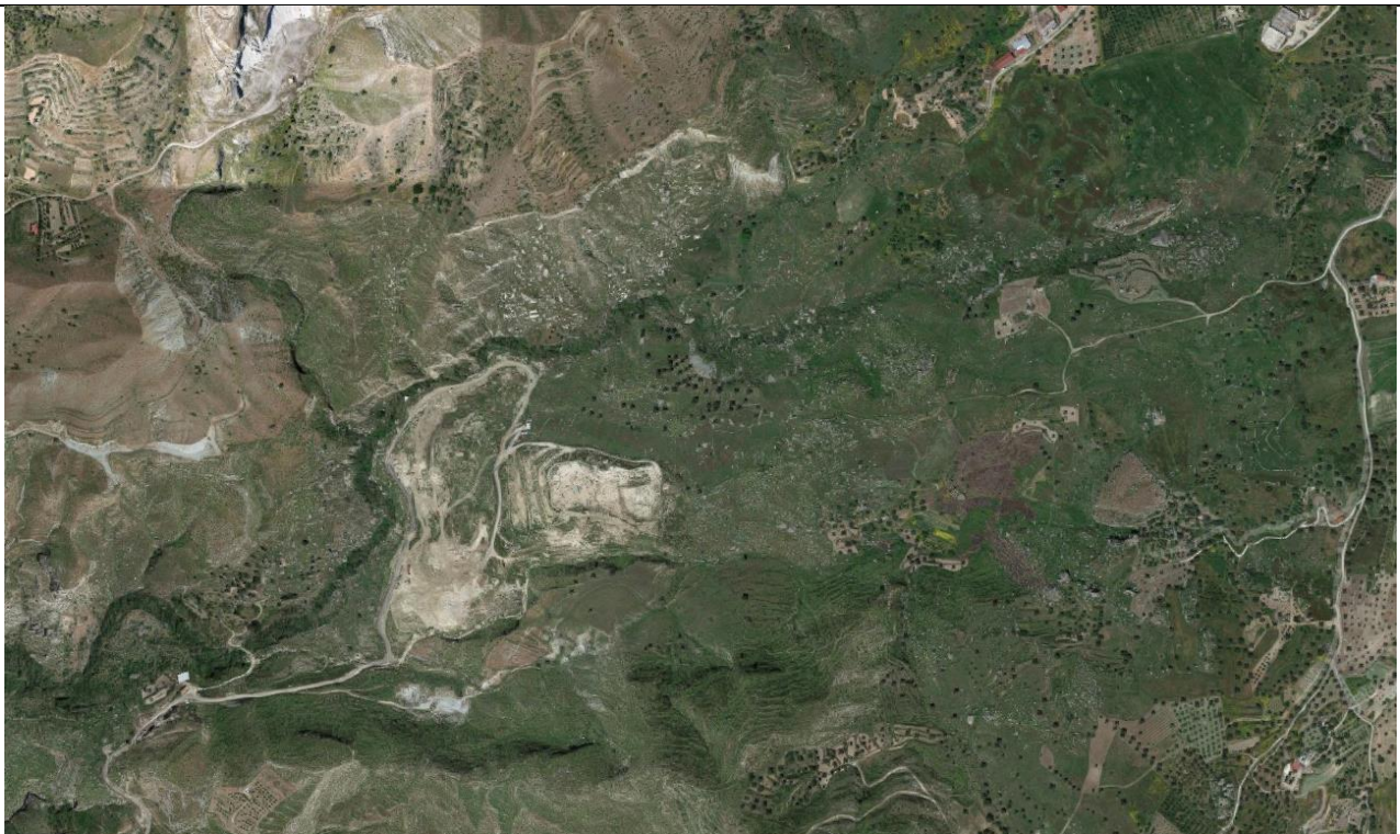
Figura 8.11 Impianto di smaltimento di Motta S. Giovanni
