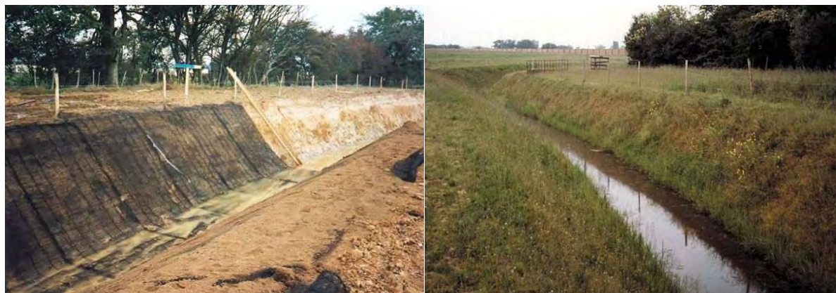
Installazione e rinverdimento di geosintetici di protezione dall'erosione superficiale (Tenax)
